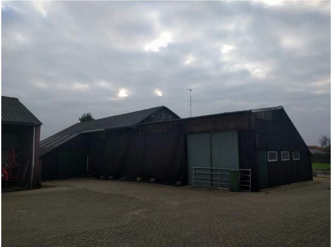
Figuur 3.4: Aanzicht van de te slopen schuur van uit het noordoosten
