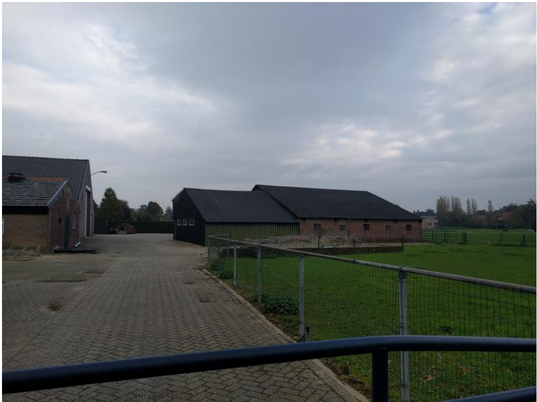
Figuur 3.3: Aanzicht van de te slopen schuur van uit het westen
