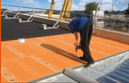
plat dak isolatie
