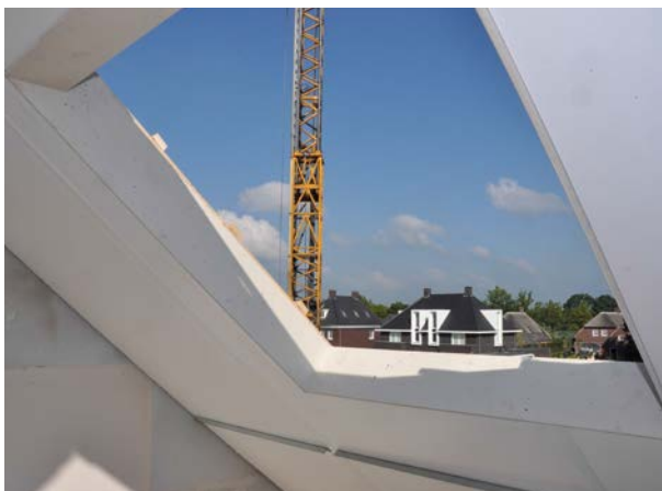
Fabrieksmatig aangebracht dakvenster met aftimmering
