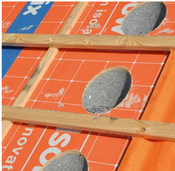
Fabrieksmatig aangebrachte, projectspecifieke doorvoersparingen.
