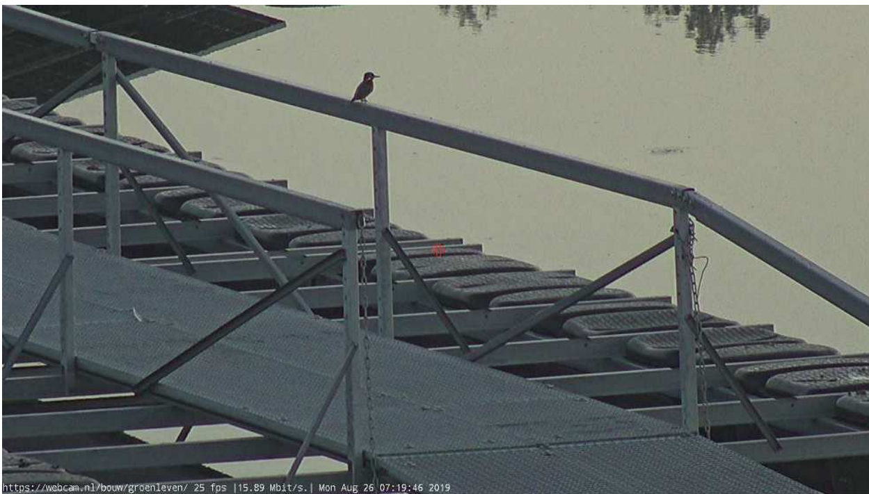
Figuur 3-3, Waarneming van een IJsvogel rustend op de brugleuning van het drijvende zonnepark op de Weperplas bij Oosterwolde. Foto: Groenleven BV.
