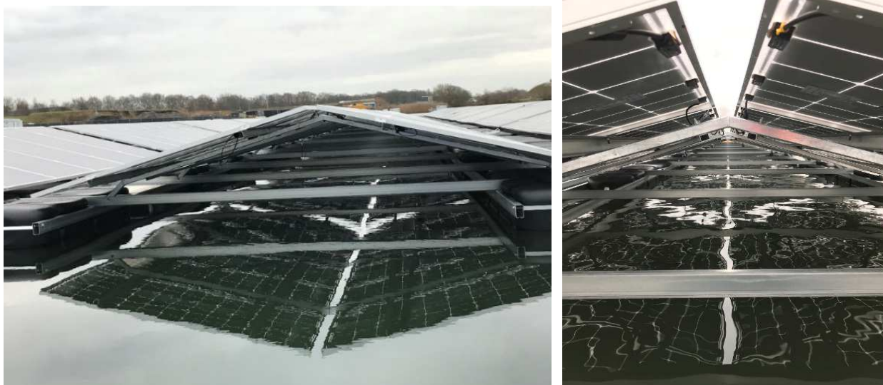
Figuur 1: Beschaduwing veroorzaakt door en lichtdoorlatendheid zonnepanelen. Foto's: GroenLeven
