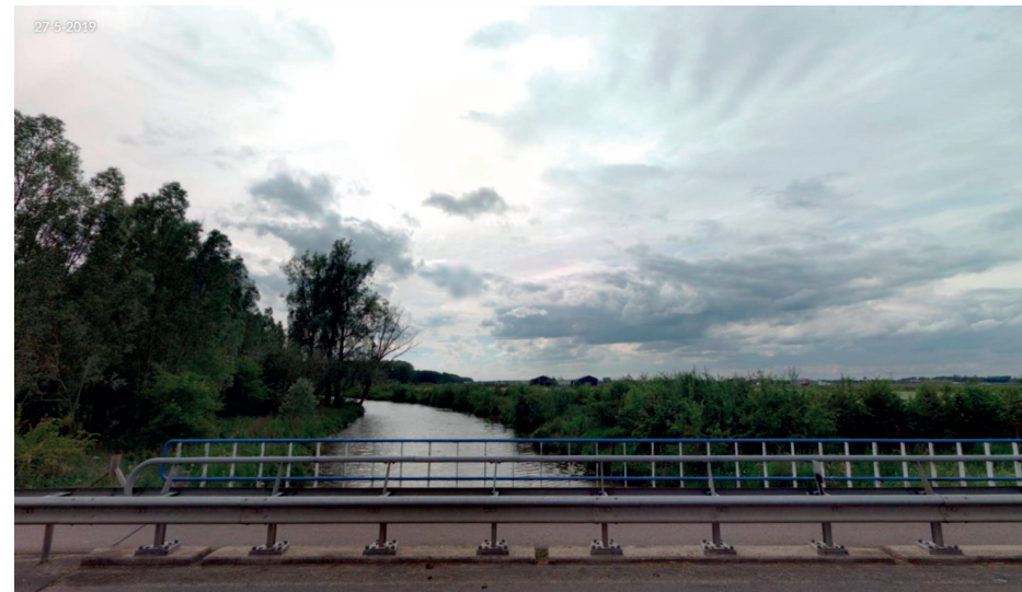
27-5-2019 Figuur 8: Foto 3 genomen vanaf de Noord-Zuid (N329) op de brug over de Rijksche Wetering aan de oostzijde van het projectgebied.
