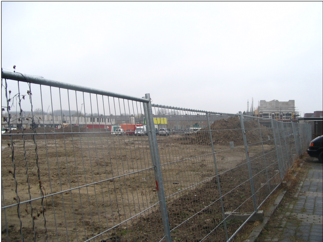
Figuur 3.1 Overzichtsfoto van het onderzoeksgebied "Heemradenstraat" gezien vanuit het zuidoosten (foto: drs. C.C. Kalisvaart, 26-02-2008). De storthopen afkomstig van de omringende bouwwerkzaamheden zijn duidelijk op de foto te zien.
