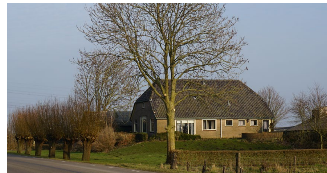
Bebouwing op een terp in de Mastenbroekerpolder.
