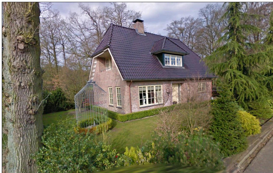
Aanzicht bedrijfswoning (bron: Google streetview)
