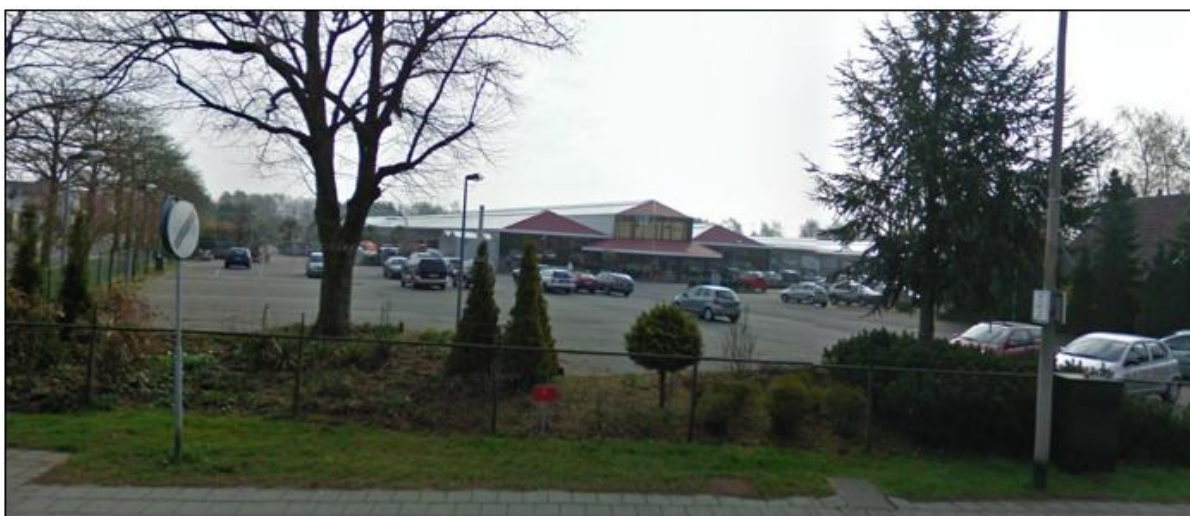
Figuur 2.3 Vooraanzicht van de huidige situatie (Bron: Google Streetview)
