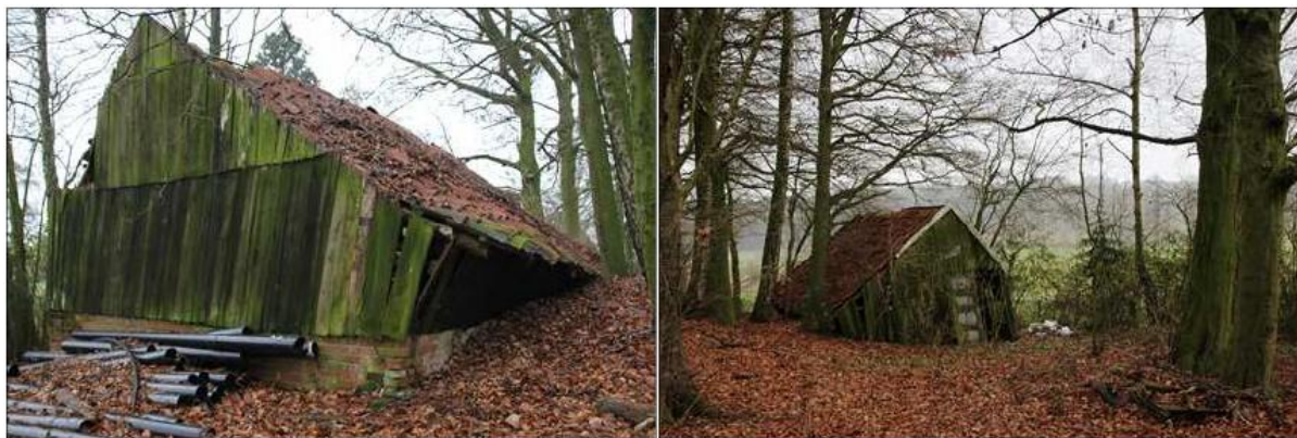
Afbeelding 2.7: Te slopen kippenschuur (Bron: Natuurbank Overijssel)
