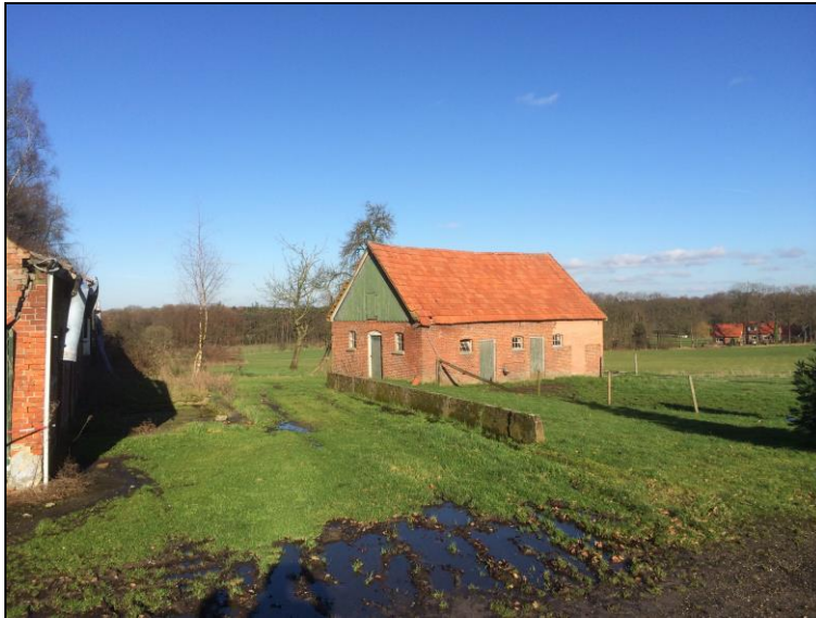
Figuur 3 Te slopen stal
