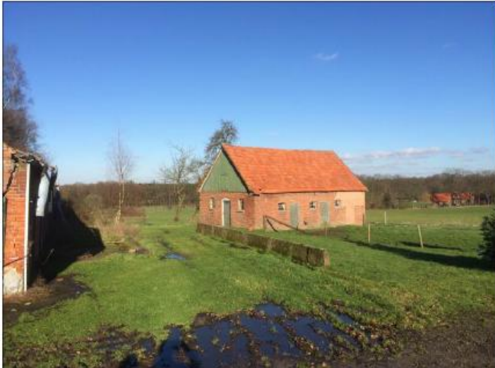
Afbeelding 2.5: Te slopen varkensschuur (Bron: Buro Stad + Land)
