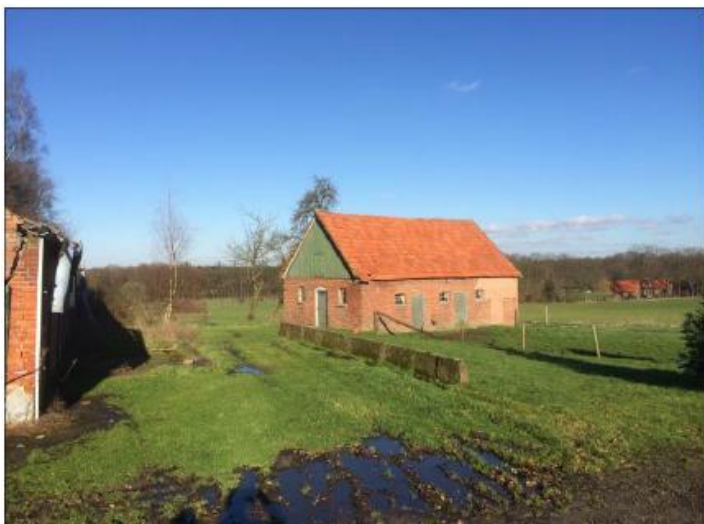
Afbeelding 2.5: Te slopen varkensschuur (Bron: Buro Stad + Land)
