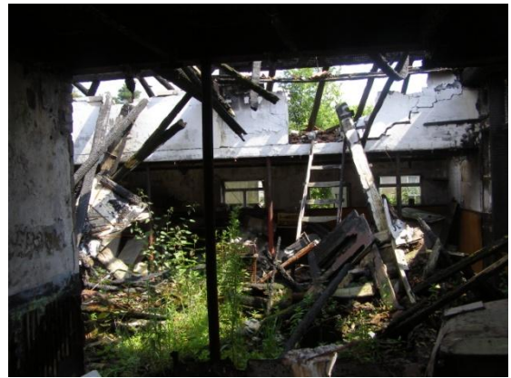
Afbeelding 6: Te slopen veestallen aan de Koppelboerweg.
