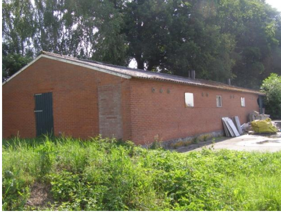
Afbeelding 3: te slopen varkensstal aan de Nijenhaerweg
