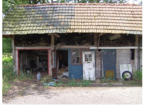
Afbeelding 5: Te slopen kapschuur aan de Koppelboerweg
