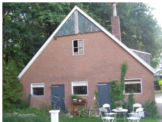
Afbeelding 1: te slopen berging aan de Nijenhaerweg
