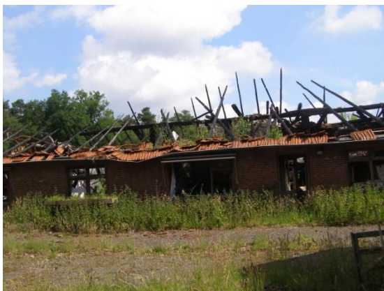
Afbeelding 5: Te slopen woning aan de Koppelboerweg
