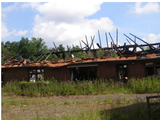
Afbeelding 5: Te slopen woning aan de Koppelboerweg
