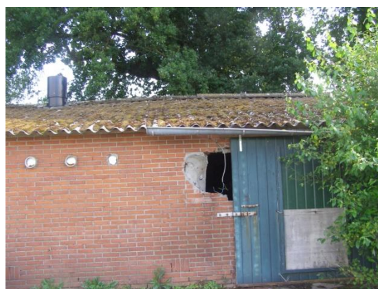
Afbeelding 3: te slopen varkensstal aan de Nijenhaerweg
