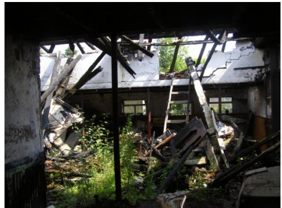
Afbeelding 6: Te slopen veestallen aan de Koppelboerweg.
