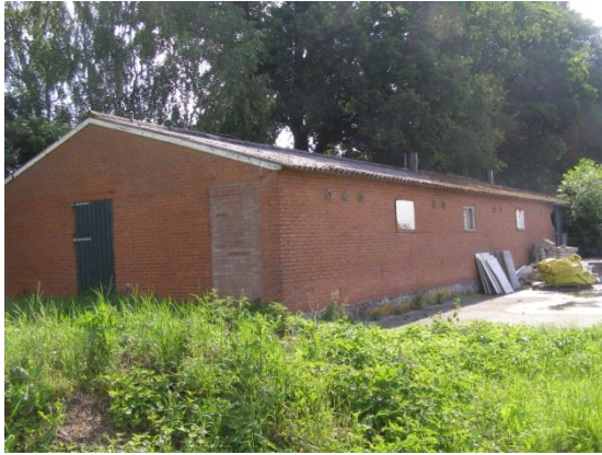
Afbeelding 3: te slopen varkensstal aan de Nijenhaerweg
