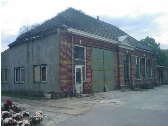
Foto 3: Aanzicht van de Zoekerschool vanuit ongeveer dezelfde richting als foto 1. Dit gebouw heeft geen spouw of dakbeschot.
