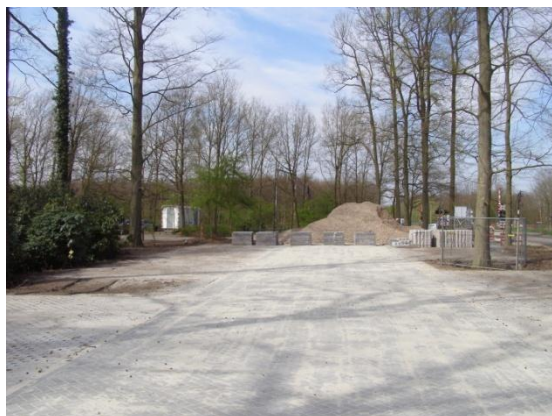
Afbeelding 1: overzichtsfoto van de nieuwe (inmiddels gerealiseerde) parkeerplaats.
