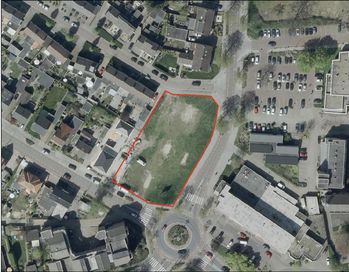
Afbeelding 2.2 Luchtfoto huidige situatie in het projectgebied (Bron: Provincie Overijssel)
