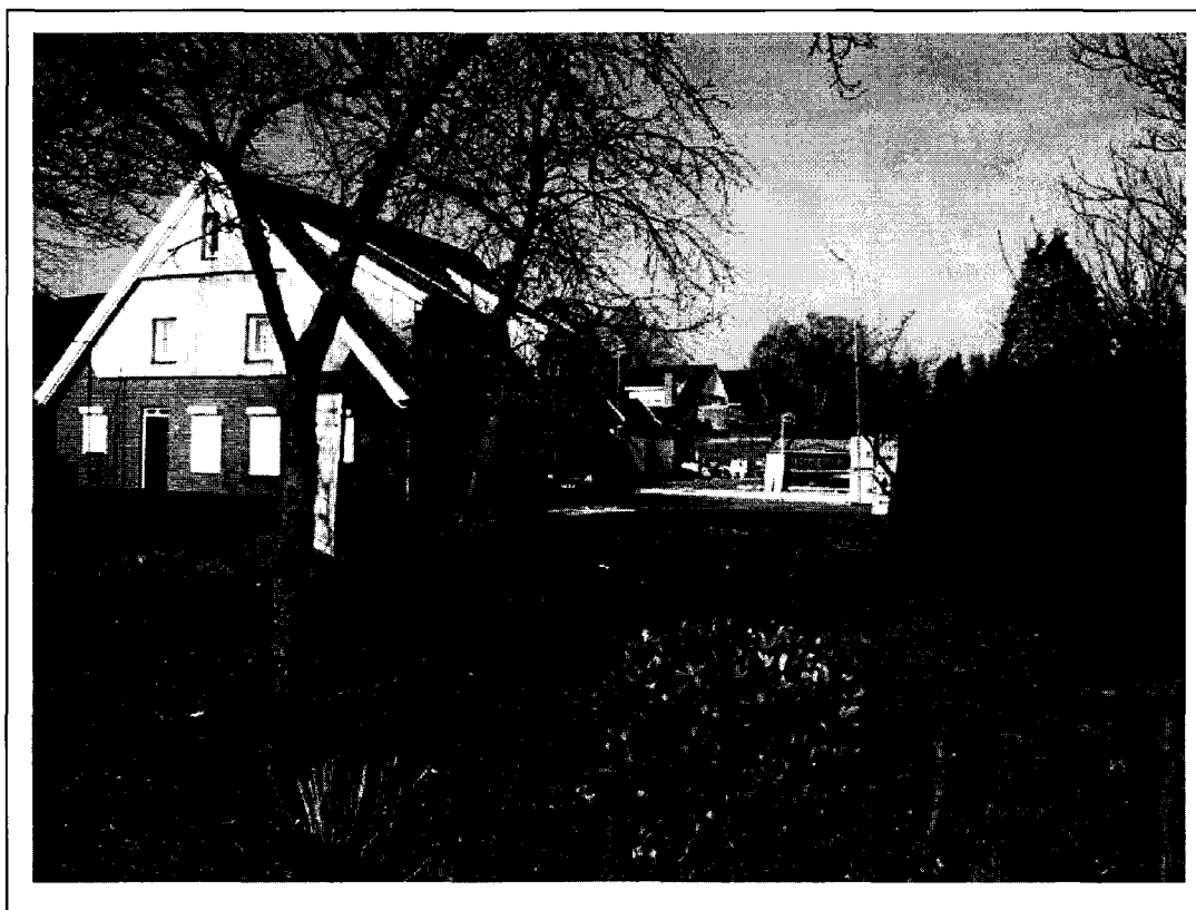
Foto 2. Woonhuis nr. 1, onderzoekslocatie aan achterzijde
