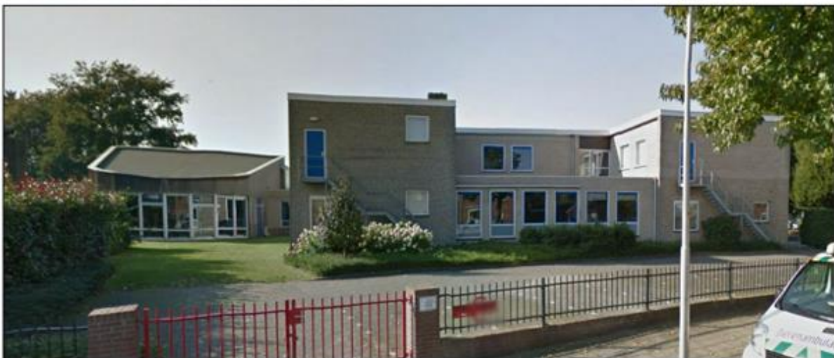
Figuur 2.2 Aanblik schoolgebouw ten opzichte van de Oranjestraat (boven) en Kloppenstraat (onder) (Bron: Google Streetview)
