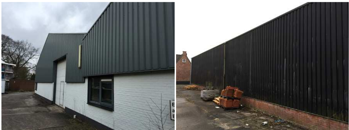
Foto links: bakstenen buitenmuur, vermoedelijk met spouw, maar geen invliegopeningen. Foto rechts: damwandgevels vormen een voor vleermuizen ongeschikte verblijfplaats.
