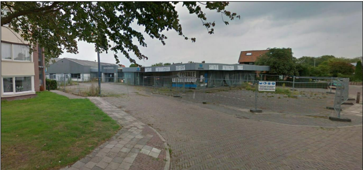
Afbeelding 2.3 Straatbeeld voormalige locatie Keizers Tegels & Sanitair voor sloop (Bron: Google Streetview – aug. 2017)
