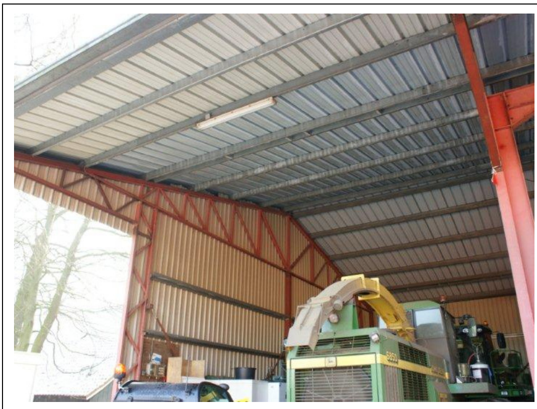
Foto 6. Binnenzijde werktuigenloods, blijft gehandhaafd
