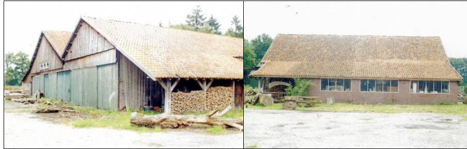
Zagerij (foto: Landgoed Het Meuleman)
