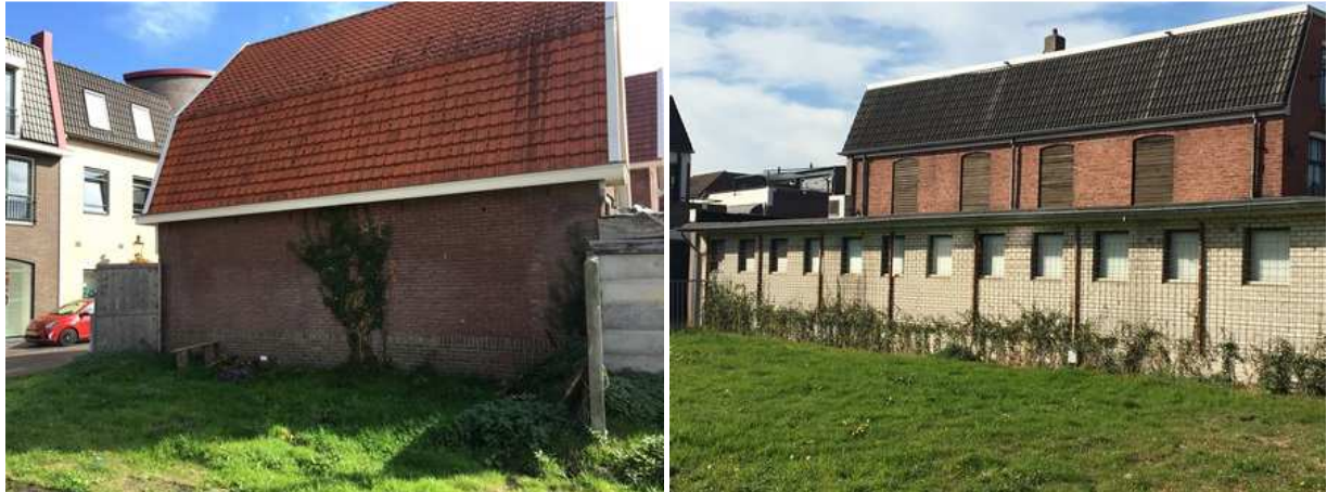
Zijgevels van bebouwing naast het plangebied. Mogelijk aanwezige verblijfplaatsen van vleermuizen in/aan deze gevels worden niet negatief beïnvloed door de voorgenomen activiteiten.
