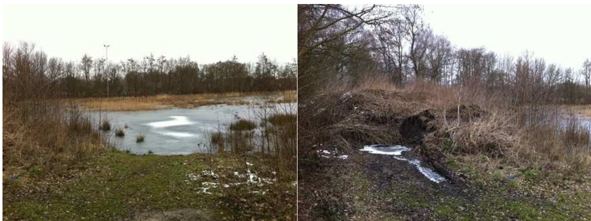
Aanzicht op de westzijde. Deze wordt gedeeltelijk gedempt. De opgeslagen grond aan de westzijde is ongeschikt om te benutten voor de demping; deze kan wellicht gebruikt worden om het bouwperceel op te hogen.
