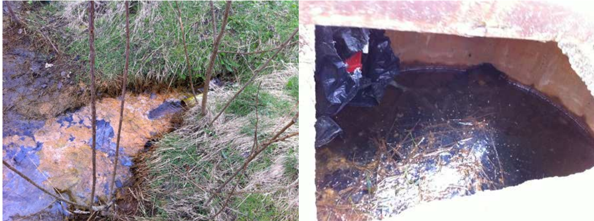
Uitstroomopening van de bron welke water aanvoert aan de voormalige visvijver.
