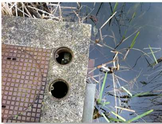
Uitlaat van de vijver. Via deze uitlaat stroomt overtollig water naar de beek te noorden van de vijver.
