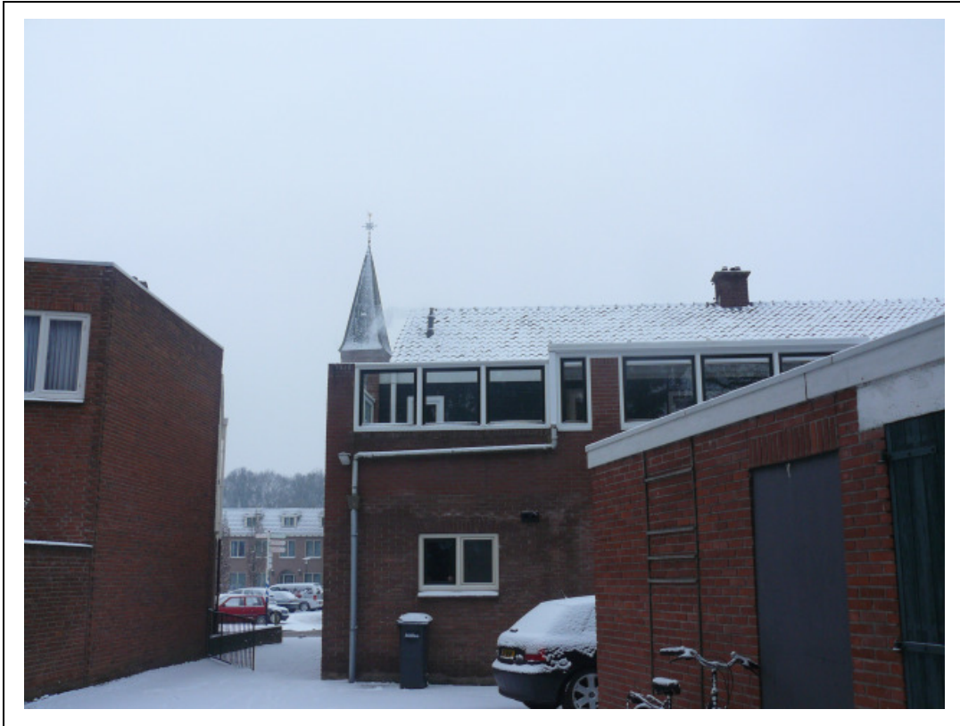
Foto 3. bouwlocatie tegen woonhuis, uitbouw met plat dak aan rechterzijde wordt gesloopt
