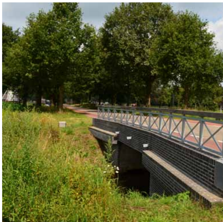
Gemetselde brugduiker Regge door Goor
