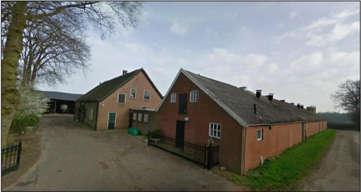
Figuur 2.2 Foto van de huidige situatie, te slopen bebouwing (Bron: Google Streetview)
