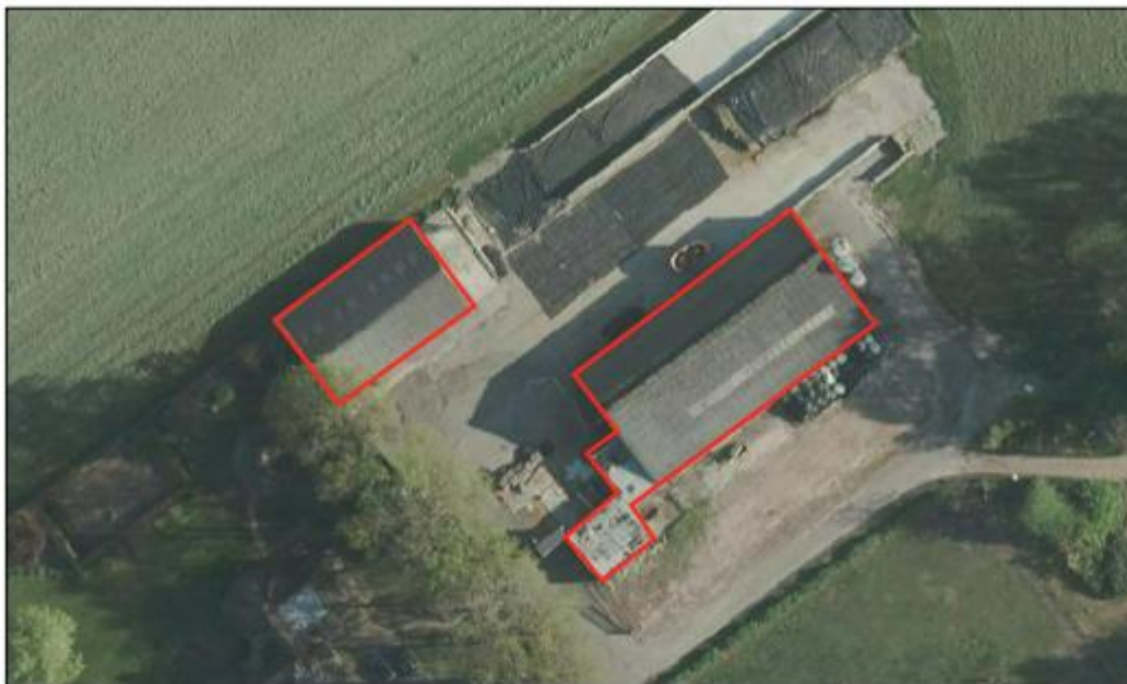
Figuur 3.1 Overzicht te slopen bebouwing (Bron luchtfoto: Provincie Overijssel)
