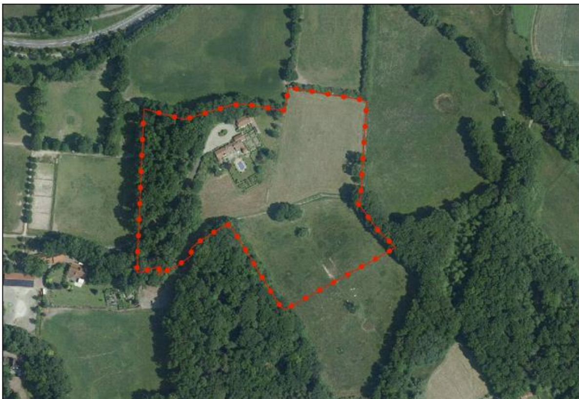
Figuur 2.2 Bestaande situatie (Bron luchtfoto: Provincie Overijssel)
