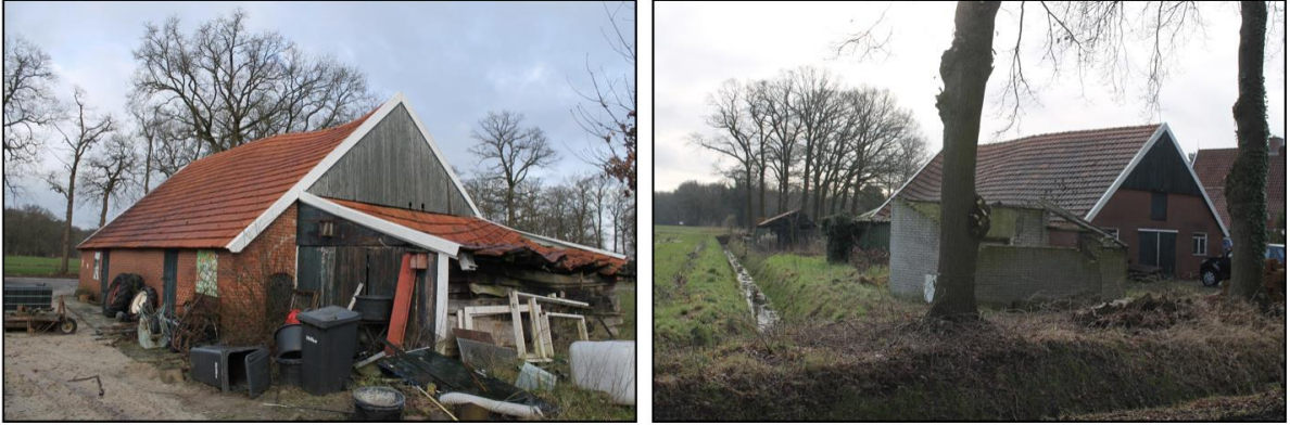
Afbeelding 2.3 Bestaande bebouwing. Links: vervallen schuur. Rechts voormalig boerderij (Bron: initiatiefnemer)
