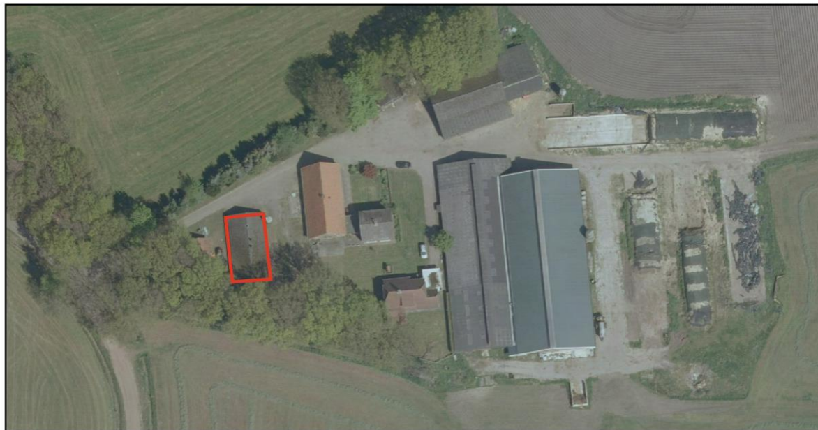
Afbeelding 3.1 Overzicht te slopen bebouwing Stroothuizerweg 45 (Bron luchtfoto: Provincie Overijssel)
