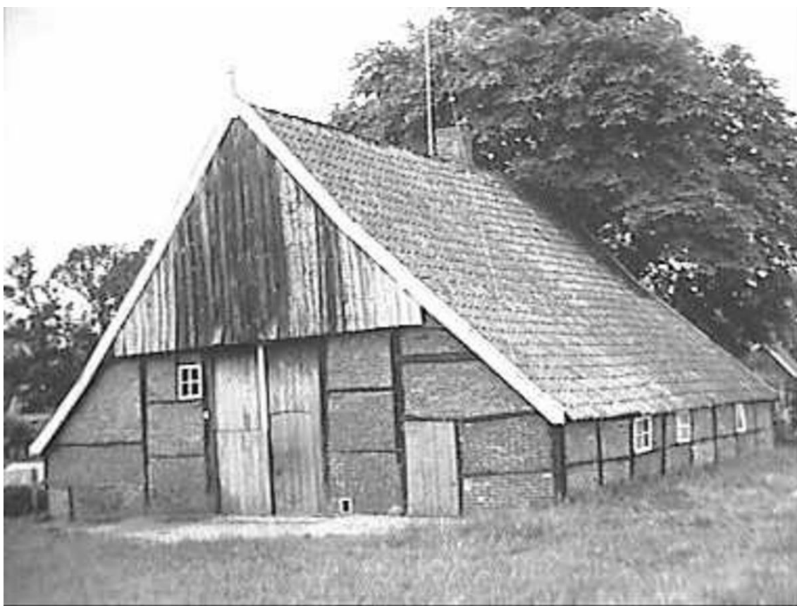
Afbeelding 2.11 Historische foto achterzijde boerderij (bron gemeente Losser)
