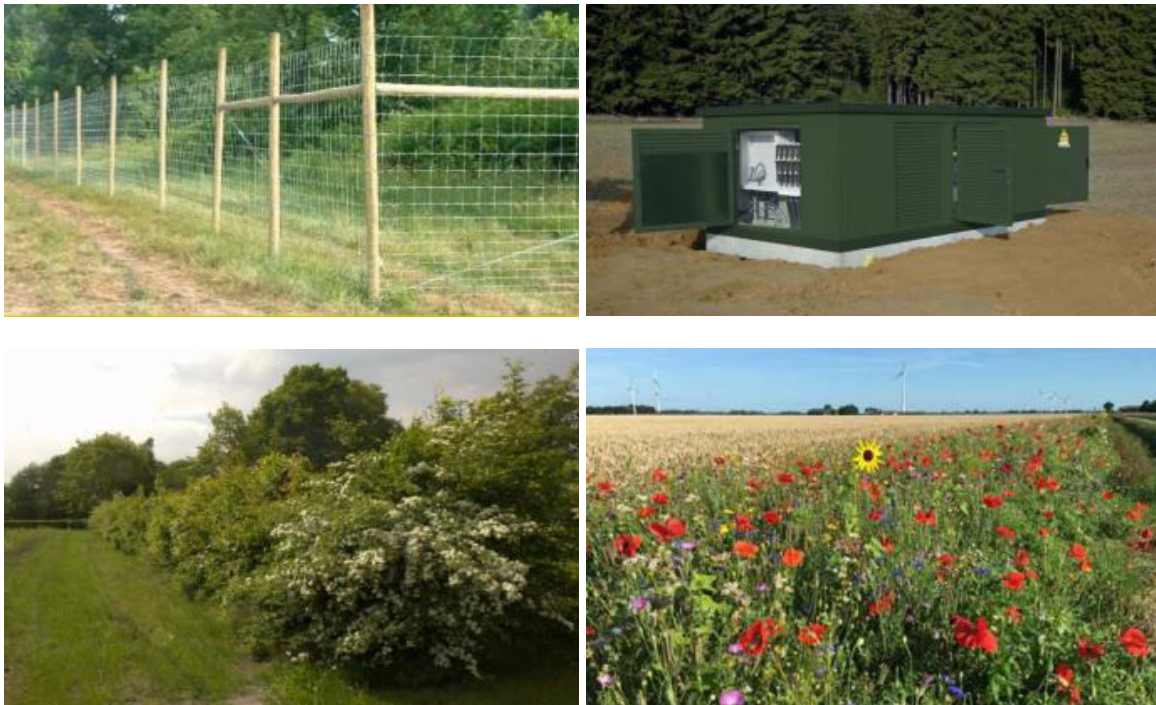
Afbeelding 17: Voorbeeld hekwerk, trafostation, wilde natuurlijke haag en kruidenbeplanting
