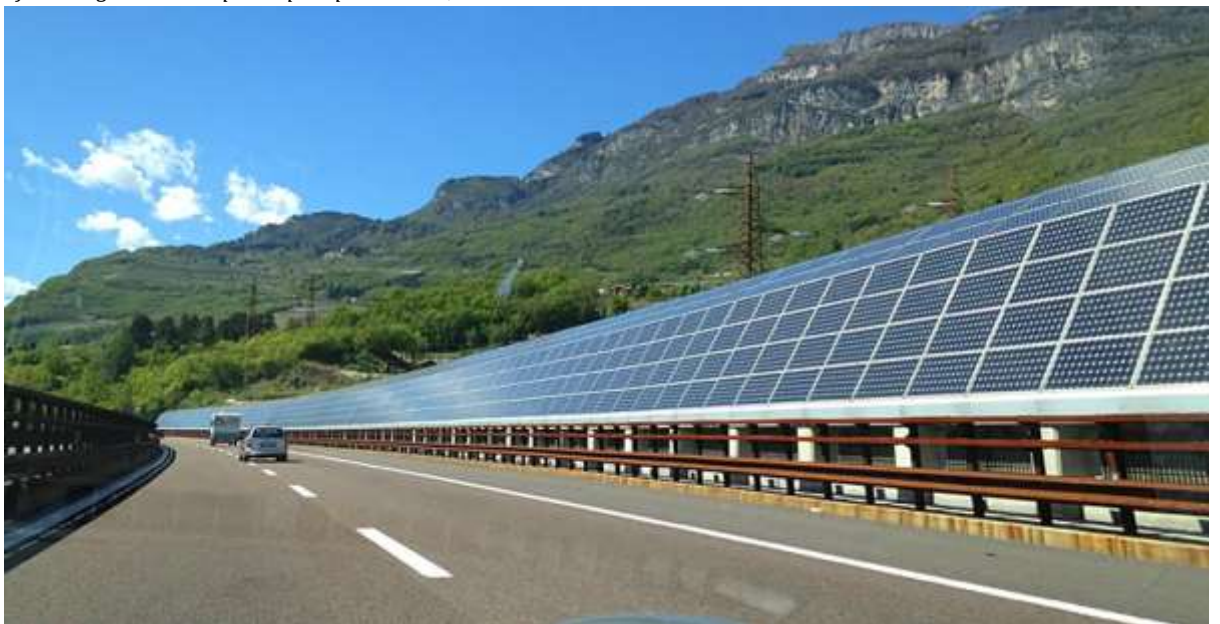
Afbeelding 3.5.: Zonne installatie langs de "Brennerautobahn" in Italië
