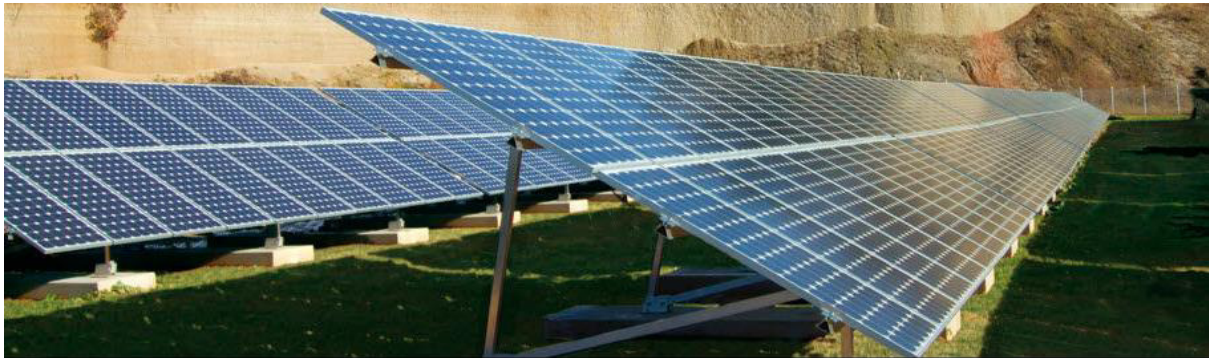
Afbeelding 23: voorbeeld onderconstructie met betonvoeten
