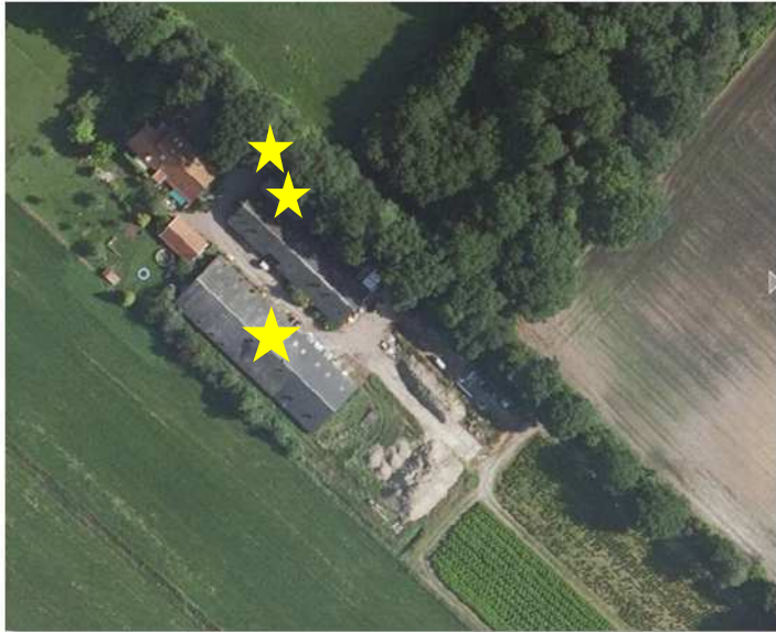
Overzicht van de te slopen gebouwen.
