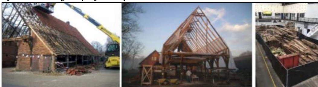
Figuur 1.2: Demontage en opslag boerderij Beernink.
