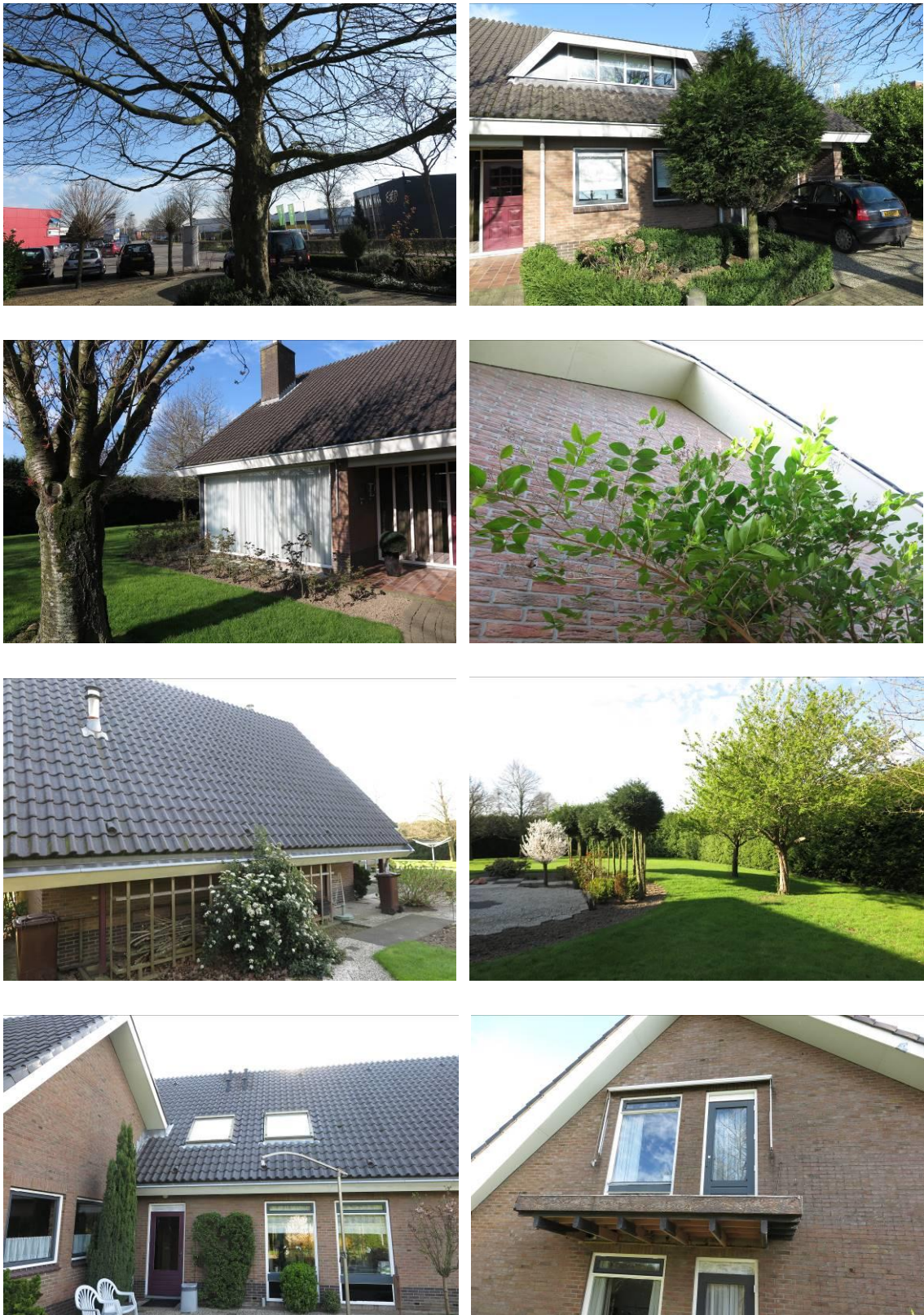
Figuur 2. Aanzicht van het plangebied aan de Waardsedijk Oost 14 te Montfoort op 30 maart 2017.
