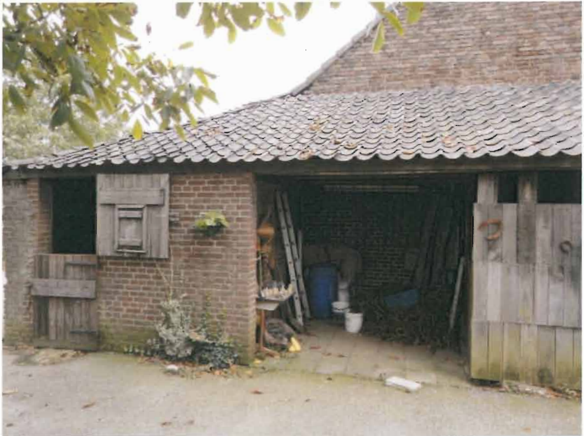
Foto 3: Paardenstal aan zuidzijde onderzoekslocatie (19 september 2011)
