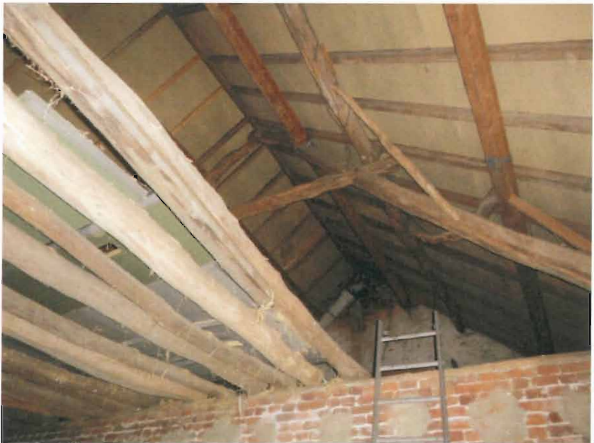
Foto 6: dakbeschot van asbestverdachte platen (19 september 2011)
