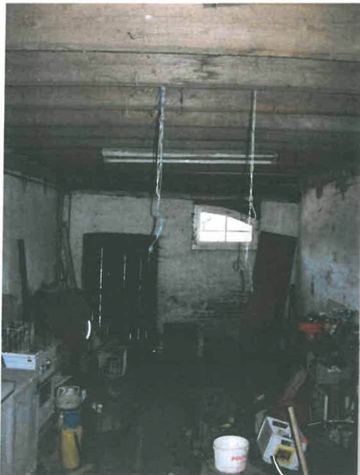
14. De koestal naar de straat gezien
