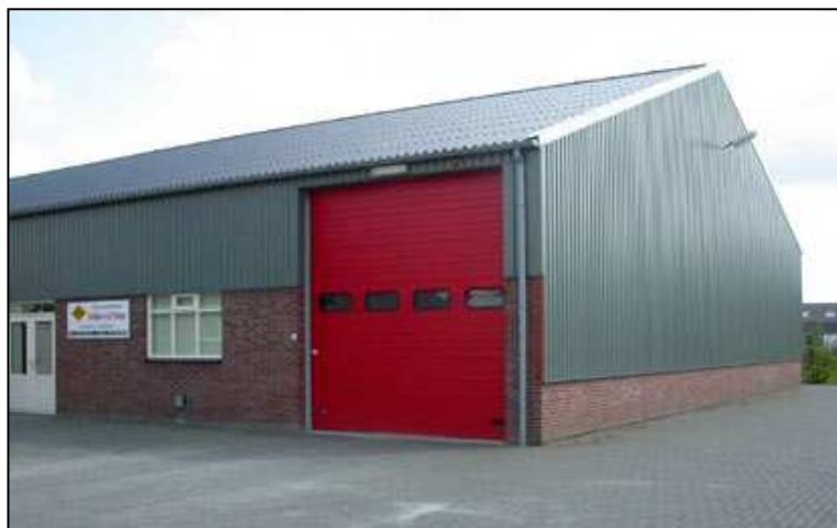
Afbeelding 4: impressie dichte gevel
