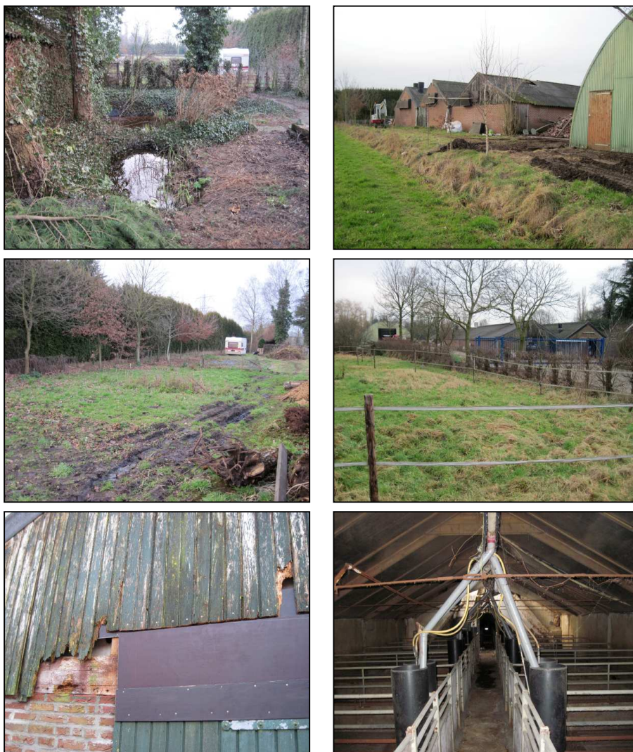
Afbeelding 10: Foto-impressie van het plangebied en de te slopen bebouwing.
