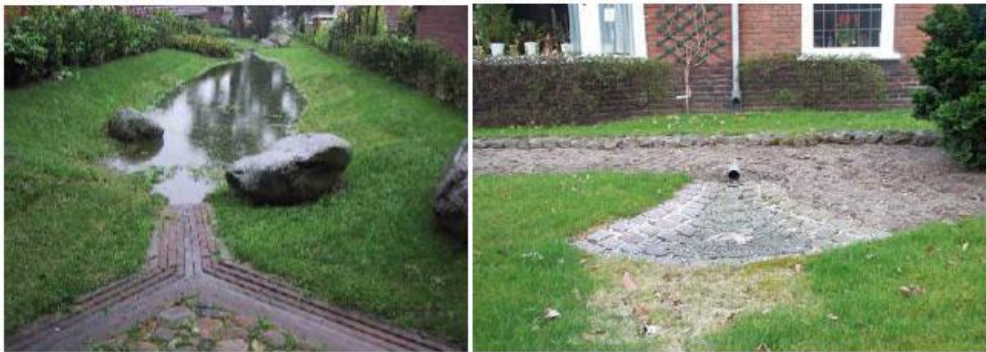
Afbeelding 2.3 en 2.4: Praktijkvoorbeelden van een bovengrondse infiltratievoorziening
