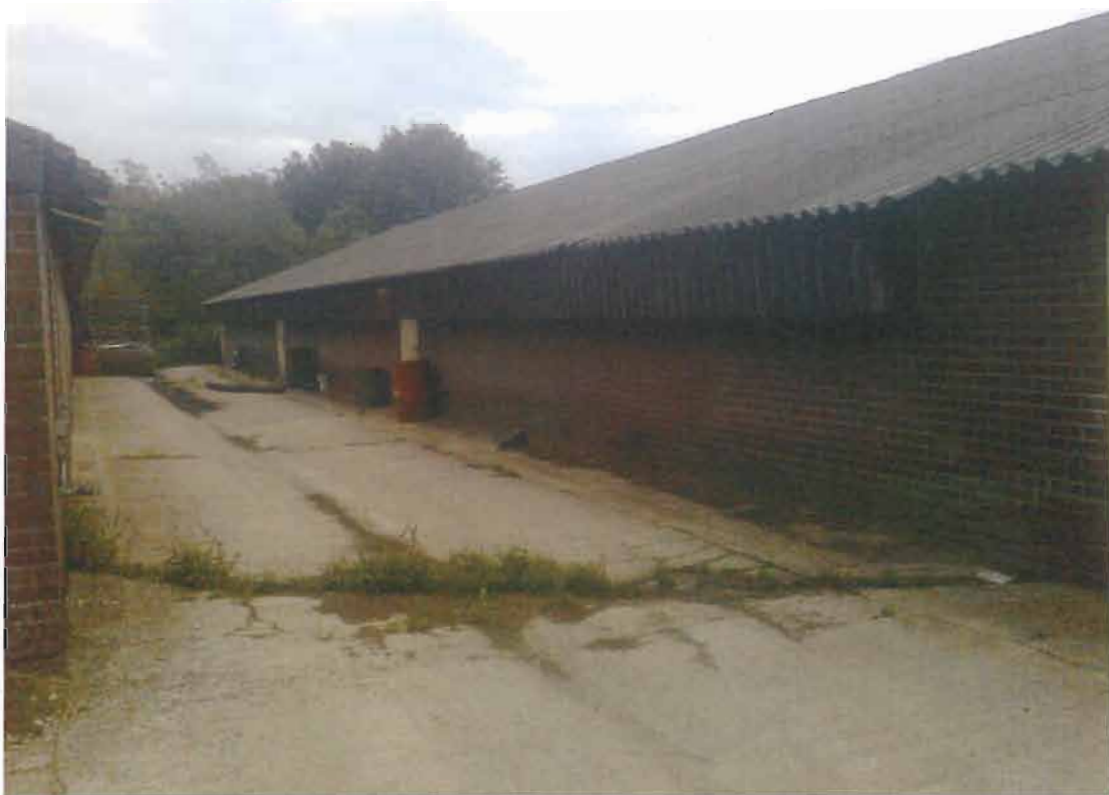
foto 3: asbestverdachte materialen aan varkensstal (27 juni 2011)
