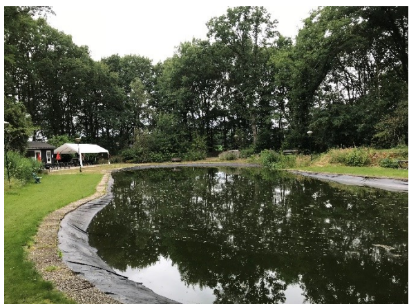
Vijver met randen van folie, aangebracht ter voorkoming instorten van de randen.
