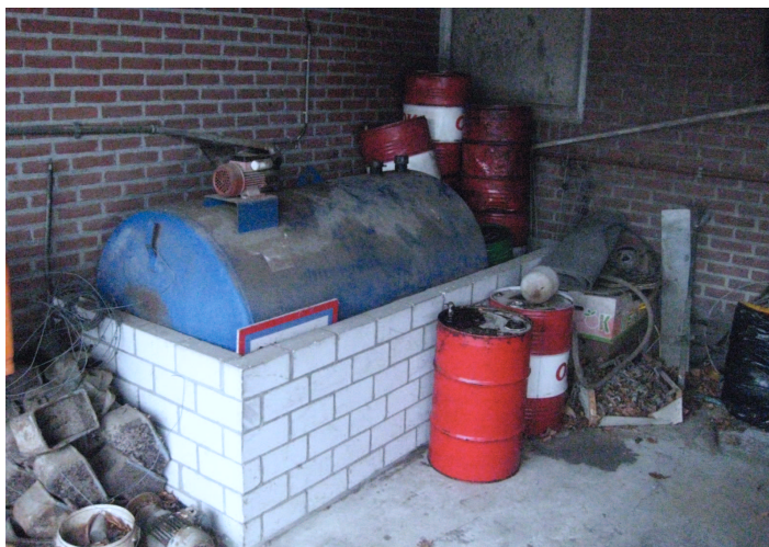
Foto 4: bovengrondse dieseltank (1.200 liter)
