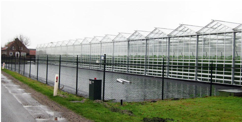
• Ingegraven waterbassin dat wegens veiligheid is afgeschermd door een rasterhekwerk.
