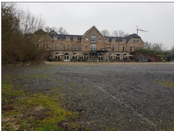
Figuur 7. Locatie 1, zijde uit te breiden gebouw
