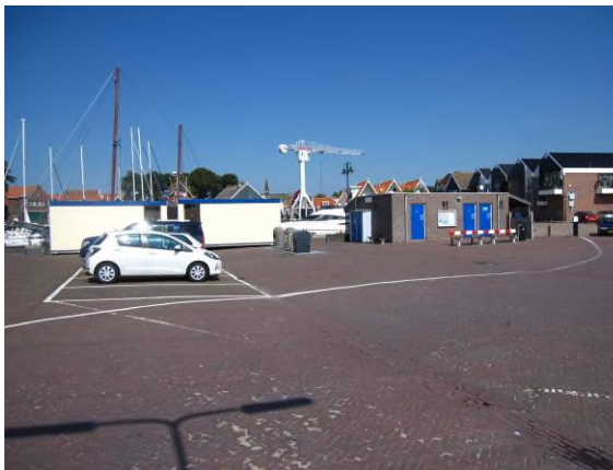
Locatie 2 vanuit het zuiden
