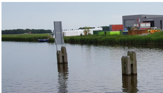
Figuur 4.3: Toegepaste afmeerstoelen bij de Zwolsebrug (fietsbrug)
