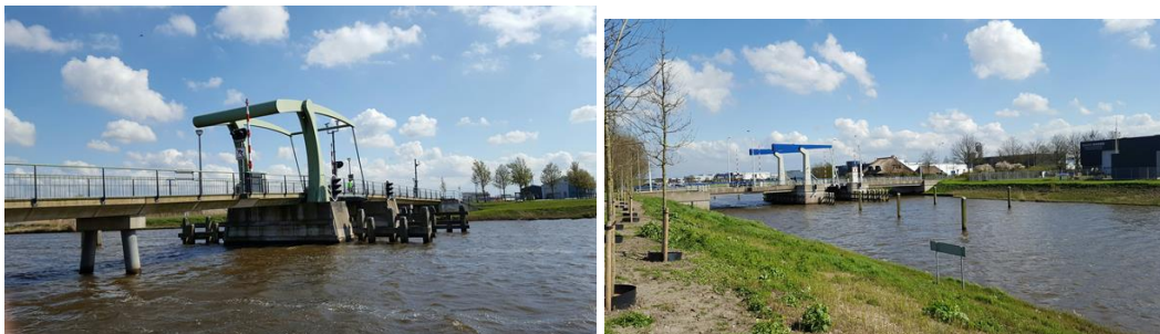
Figuur 2.2: De bestaande Zwolsebrug (links) en A. de Wit brug (rechts)
