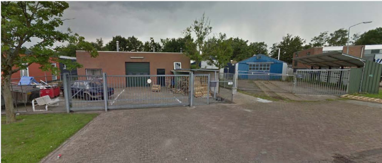
Figuur 6: Indruk Westgat 2a en 2b voormalige situatie (bron: Google Streetview)
